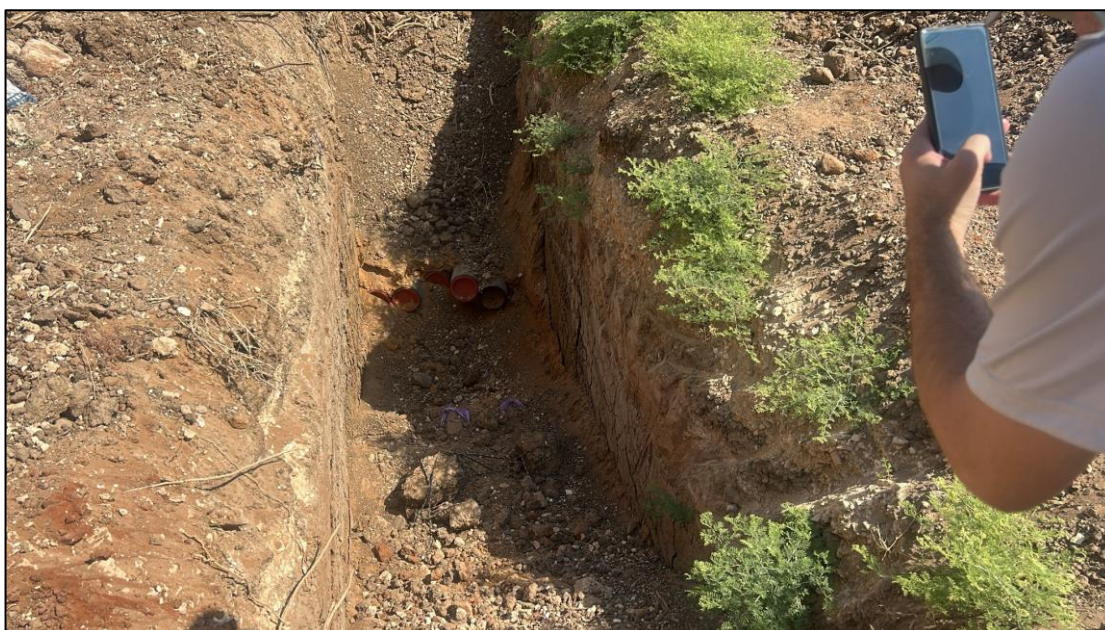
תצלום 17 - עבודות תשתית, צינורות חשופים בקרקע מכוסים פלסטיק
