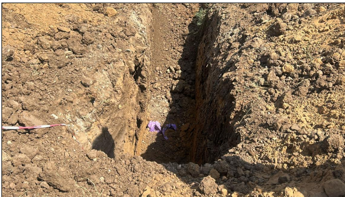
תצלום 19 - עבודות תשתית, צינורות חשופים בקרקע מכוסים פלסטיק
