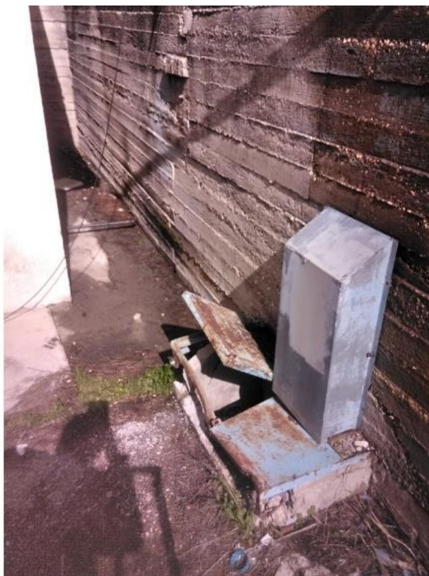
תמונה 13: נקודת פריקה/שאיבה לצד מיכל סולר עילי המיכל יושב על גבי החומה, התשתית בתחתית החומה ממערב (ראה תמונה 12)
