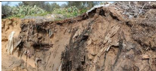
איור 93: בור YA-11 דופן מערבי של הסוללה. חוטי הדלייה, פלסטיק, שקיות ברזל, פסולת ברזל וצד גזם (1%).
