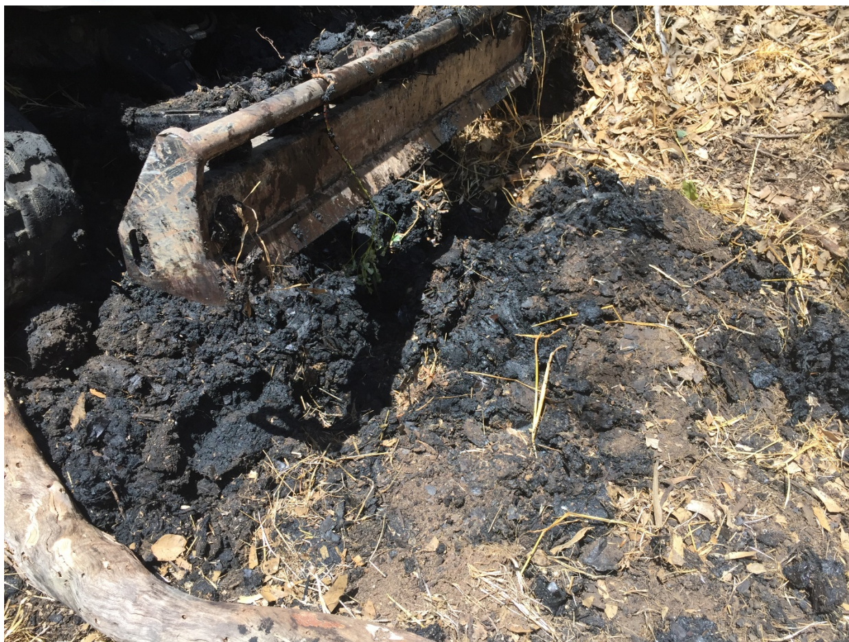
תמונה 6 : שקיעת המקדח בתוך בוצת שמן, כאשר על פני השטח ישנה שכבת קרקע ועלים.
