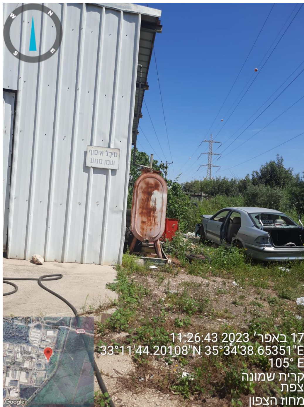
תמונה 11- מיכל איסוף שמן מנוע מוצב על גבי מאצרה על הקרקע. נראה מיושן. מימינו רכב מפורק
