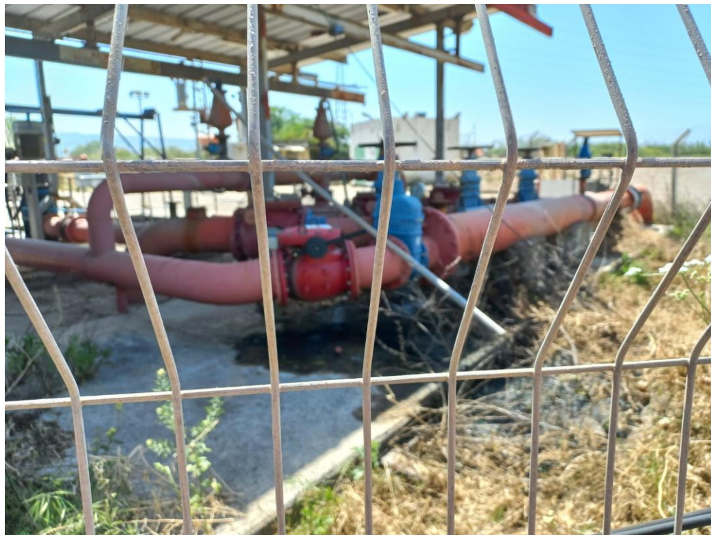
תמונה 29- תחנת השאיבה בתוך מתקן המט"ש. ניתן לראות את השפך שמתחת לצינורות
