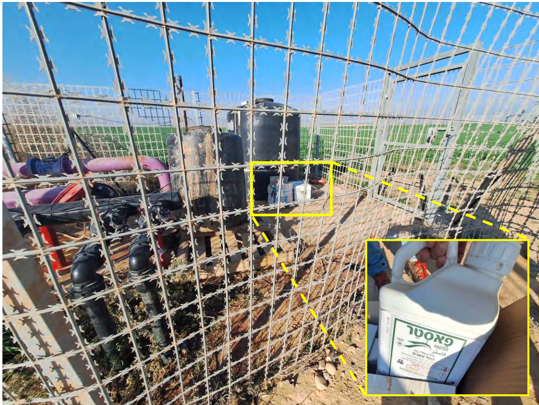
איור 13 - מיכלי "פאסטר" ממערב לאופקים.
