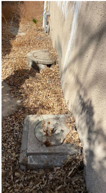
תמונה 11 – שוחות ביוב המעידות על חיבור למערכת ביוב סניטרי
