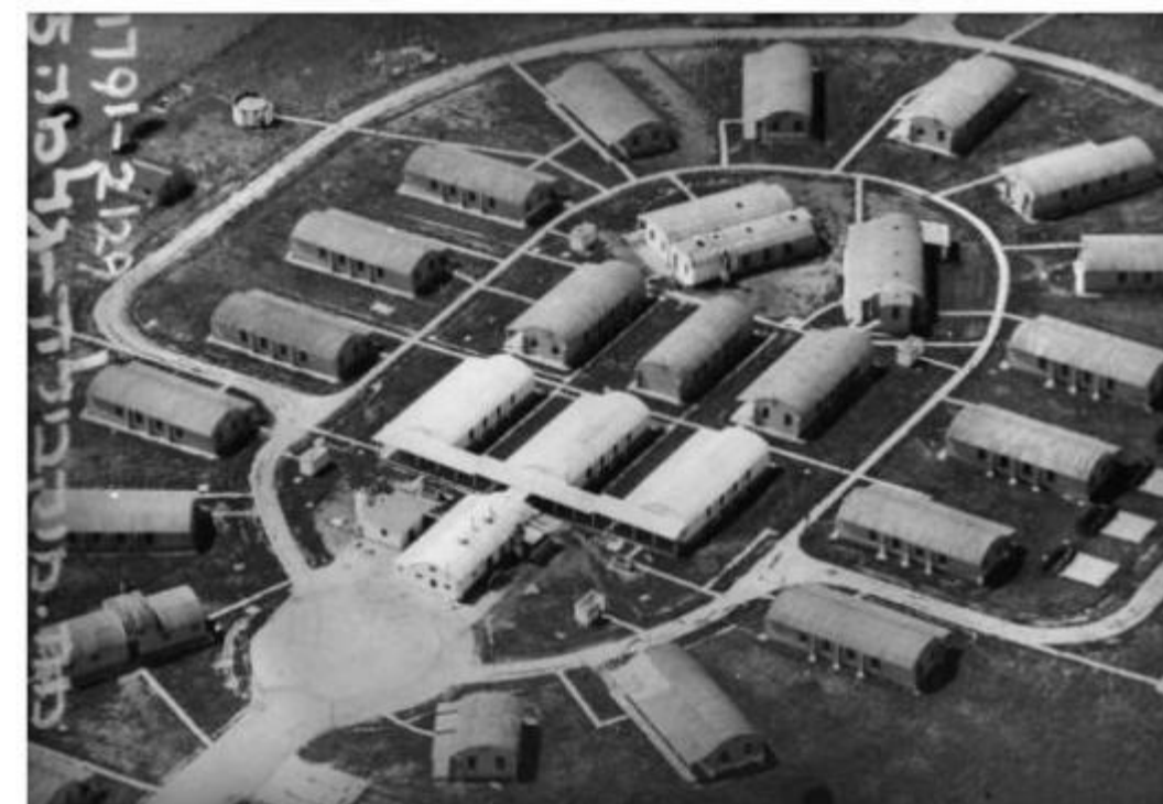
בסיס התעופה הבריטי מוקבילה, 1948. מערך צריפי ניסן בסגנון מקומי למגורים. הקמרון מפח גלי והמעטפת הקבועה של הקירות האנכיים נבנתה מלבנים עם קורות בולטות לחיזוק, עם חלונות ועם פתחים בהיקף המבנה. באדיבות ארכיון צה"ל ומערכת הביטחון.
