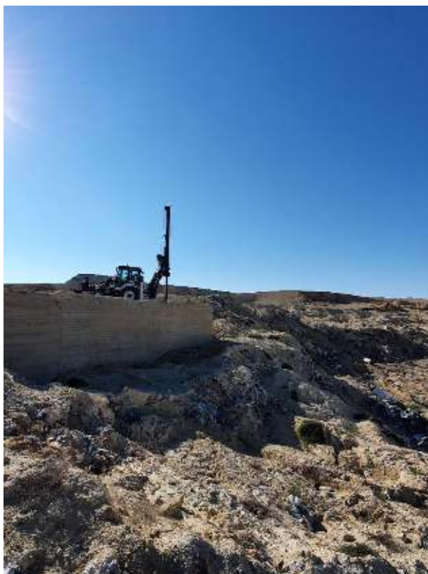
תמונה 3 – קידוח כלונסאות לאפיון פסולת (K-20 מיקום חדש)
