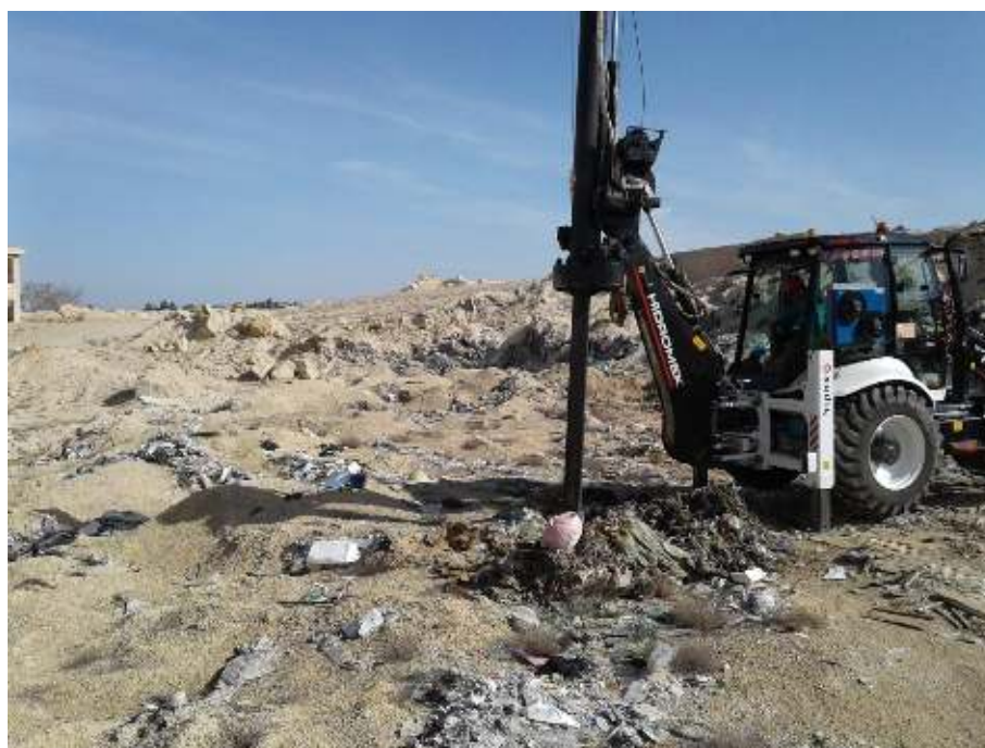
תמונה 4 – קידוח כלונסאות לאפיון פסולת (K-21)
