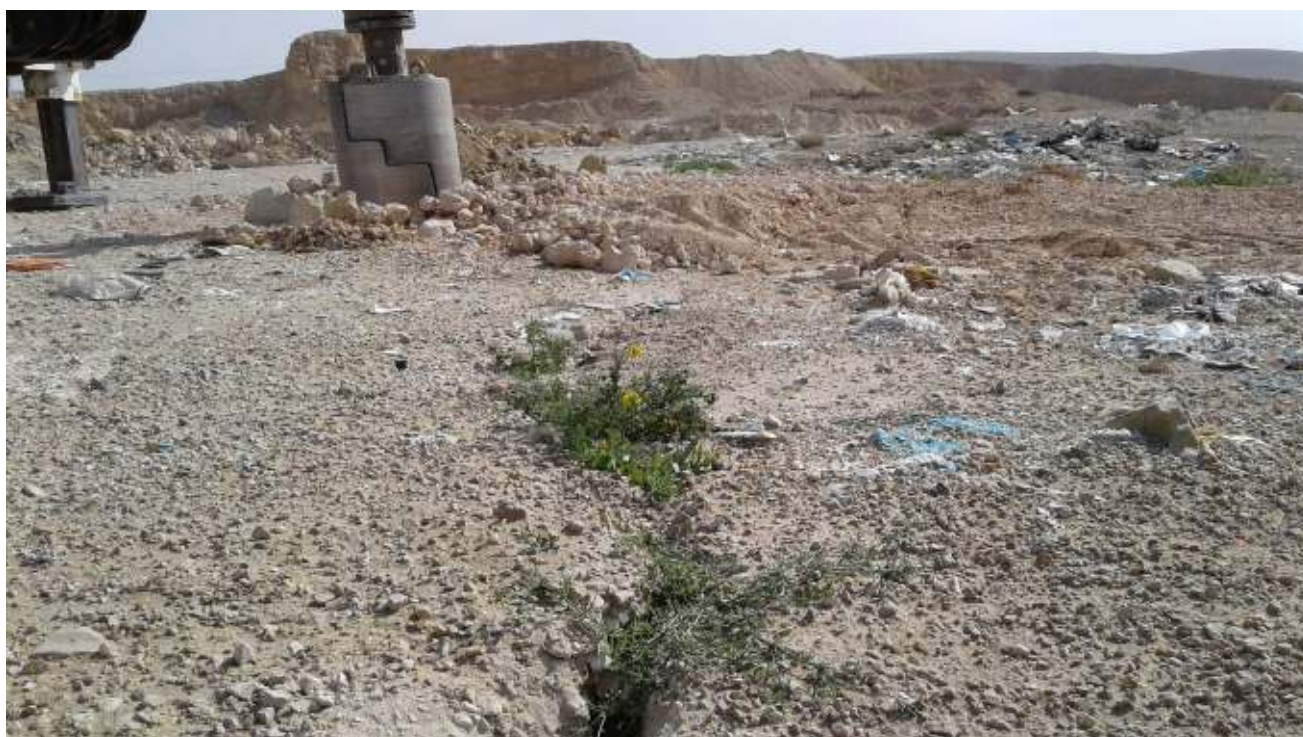
תמונה 6 – קידוח כלונסאות לאפיון פסולת (K-25)
