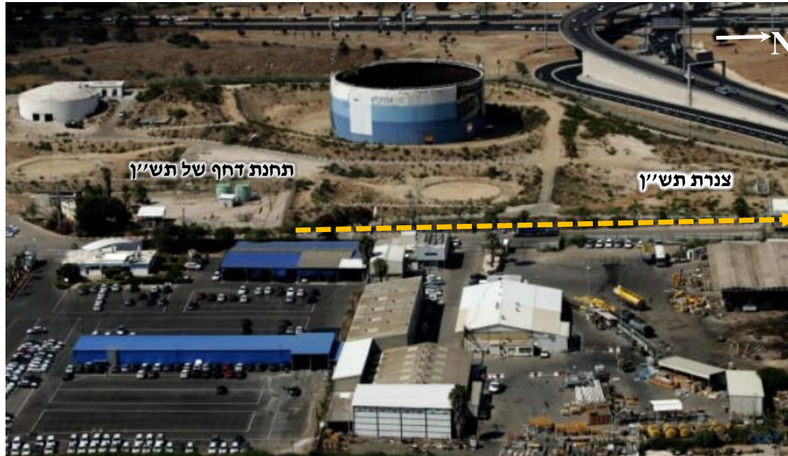
איור 9: צנרת דלק תת קרקעית של חב' תש"ן
