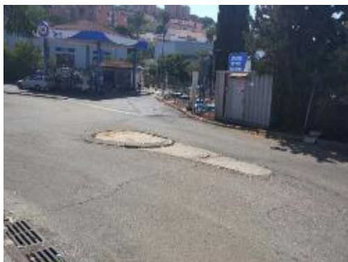
איור 31 - חוות המיכלים - 4 מיכלים עם מכסי ברזל בולטים, למיכל הסולר מחוברת מנפקה ישירות.
