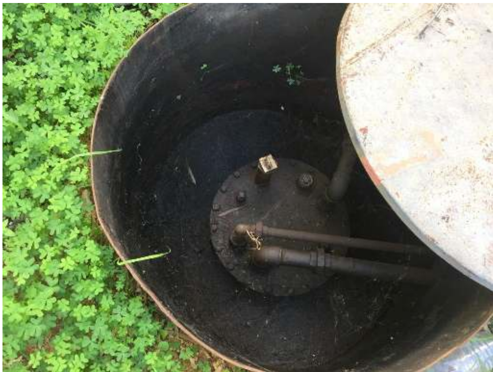
תמונה 4 – מכל סולר (צפוני) תת קרקעי, מרכז אנרגיה (מוקד 30, טבלה 1)
