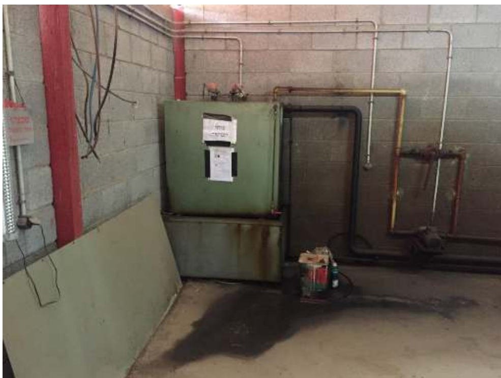
תמונה 6 – מכל סולר עילי בתוך מרכז אנרגיה (מוקד 30, טבלה 1)
