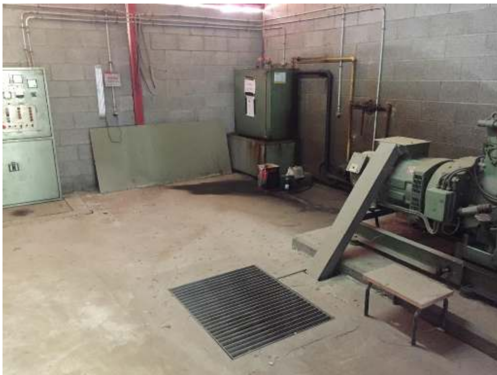
תמונה 5 – מכל סולר עילי בתוך מרכז אנרגיה (מוקד 30, טבלה 1)
