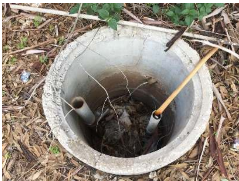
תמונה 14 – מכל סולר תת קרקעי, מערבית לבריכת השחיה (מוקד 30, טבלה 1)
