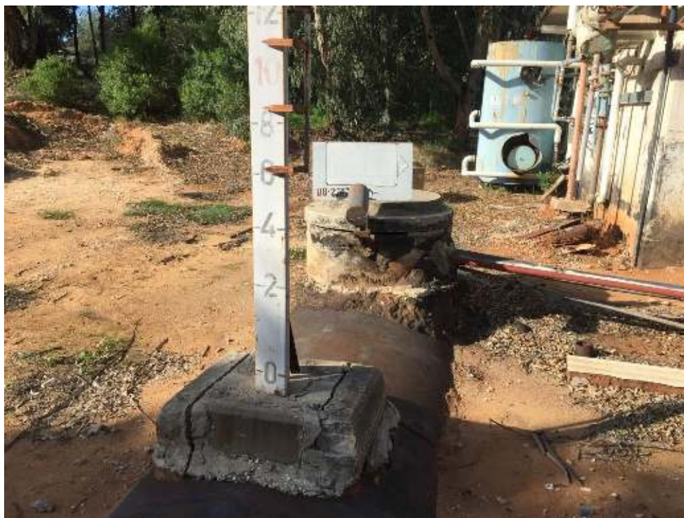
תמונה 7 – מכל סולר (דרומי) תת קרקעי, מרכז אנרגיה (מוקד 30, טבלה 1)
