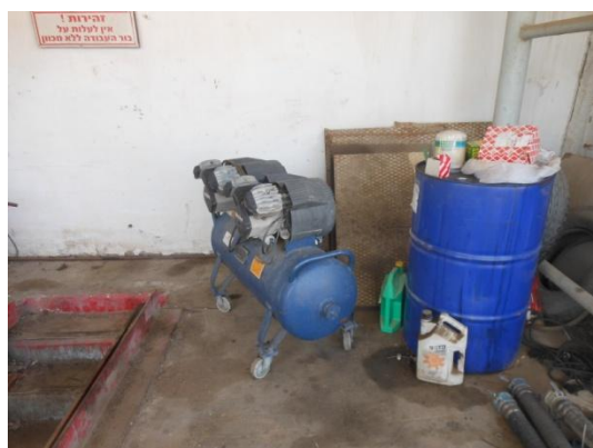
איור 4-4.5.1: סככת העבודה.
