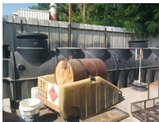
איור 11-4.4.2: משטח בטון ממערב למוסכים. עליו ממוקם מפריד בדלקים שמנים ועמדת השטיפה.
