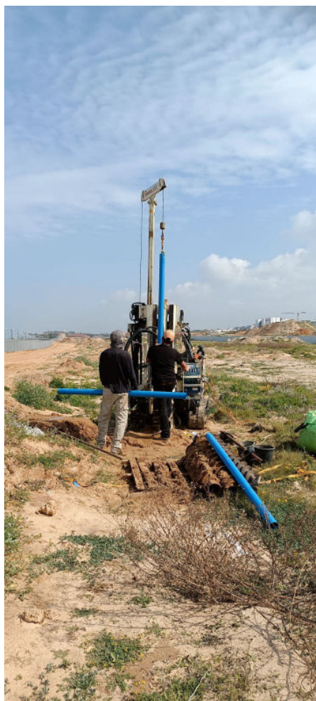
איור 5: התקנת פיאזומטר בקידוח W2
