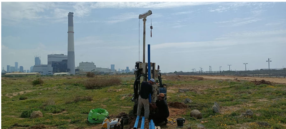
איור 6: התקנת פיאזומטר בקידוח W6
