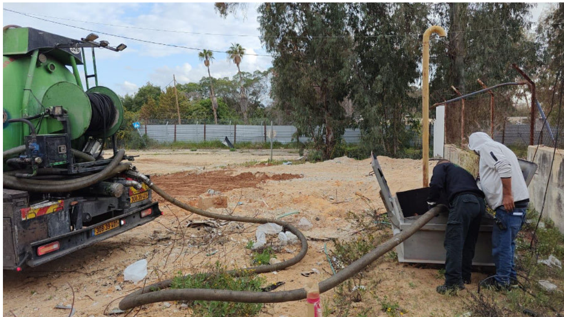
איור 10 – שאיבת נוזלים מהמכל טרם שליפתו מהקרקע
