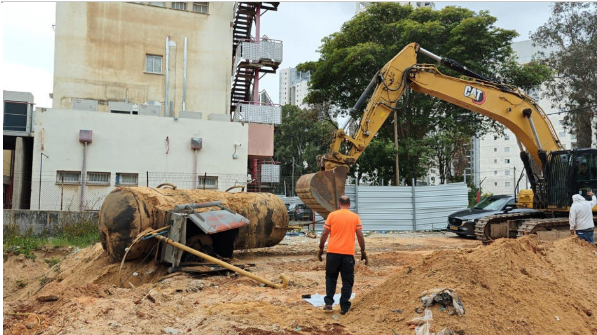
איור 11 – המכל התת קרקעי לאחר שליפתו
