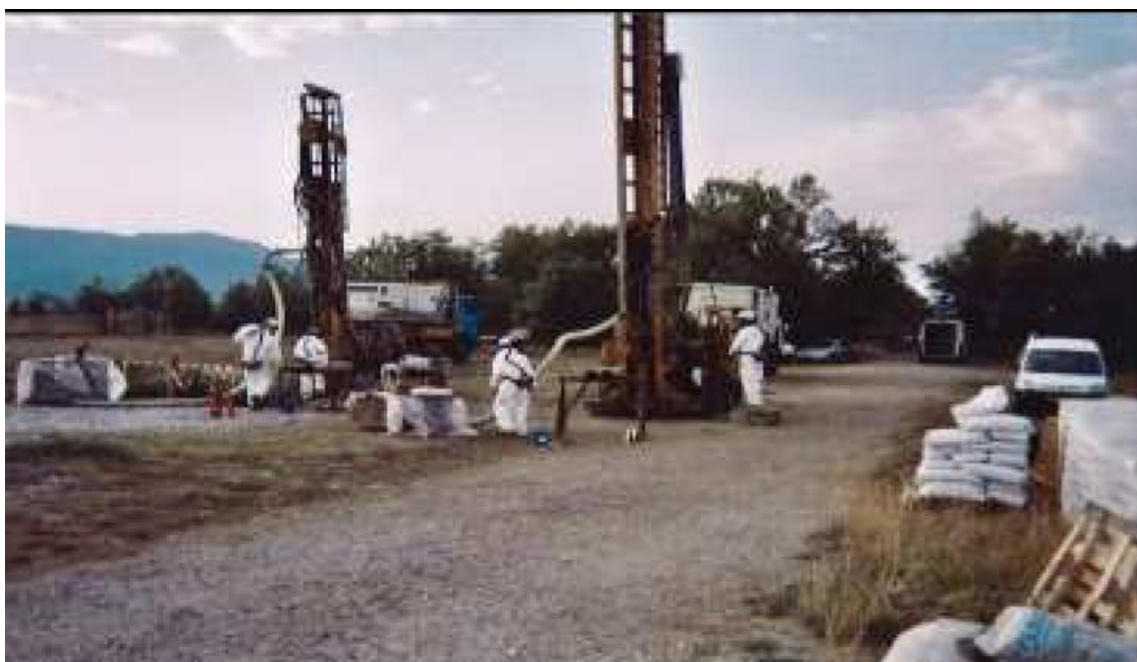
איור 49: חברת HPC שיקום קרקע בשיטת TMT15-Stabilization
