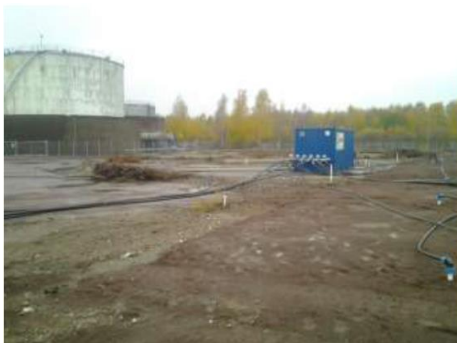
איור 12 : מתקן Bio-Venting של חברת RGS90
